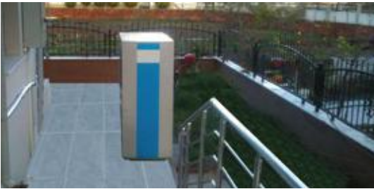
Monoblok Tip Hava Kaynaklı Isı Pompası
