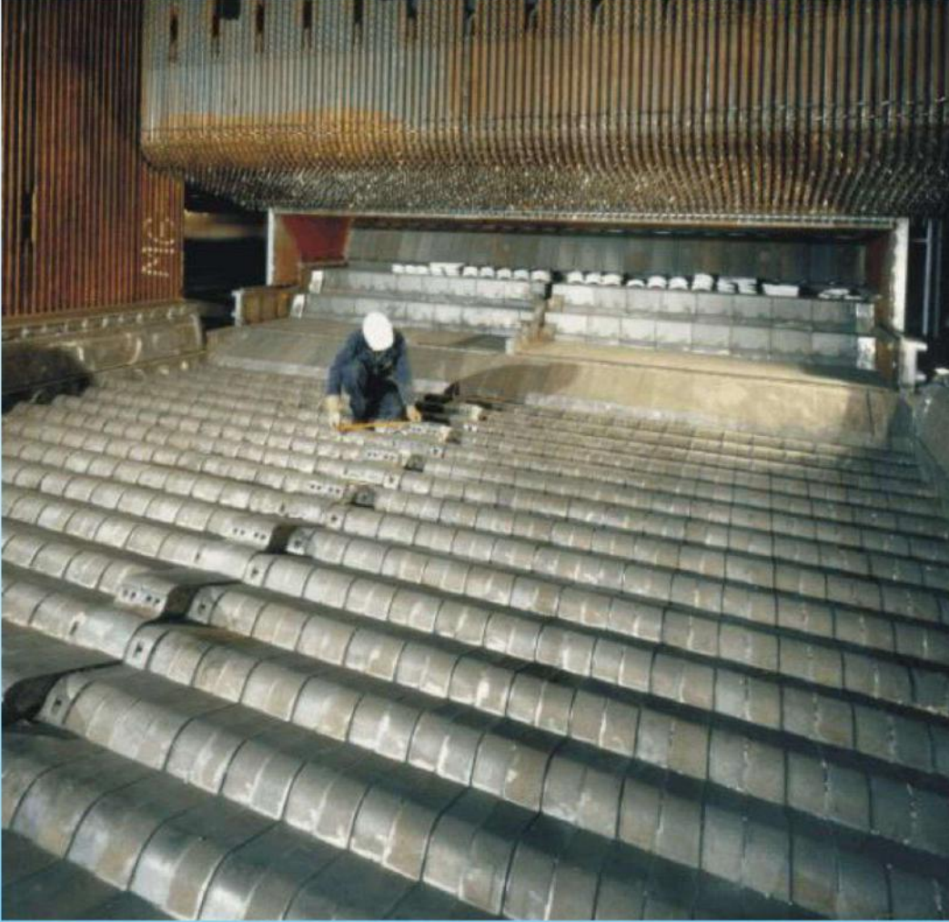
Yanma odası içi hareketli ızgaralar
